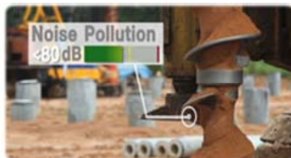
ควบคุมมลภาวะทางเสียง
